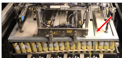
Fig. 57: Anomalia nel sollevamento del telaio di copertura Motivo: nastro di reggiatura perimetrale dimenticato e non tolto da una pila di recipienti nuovi
